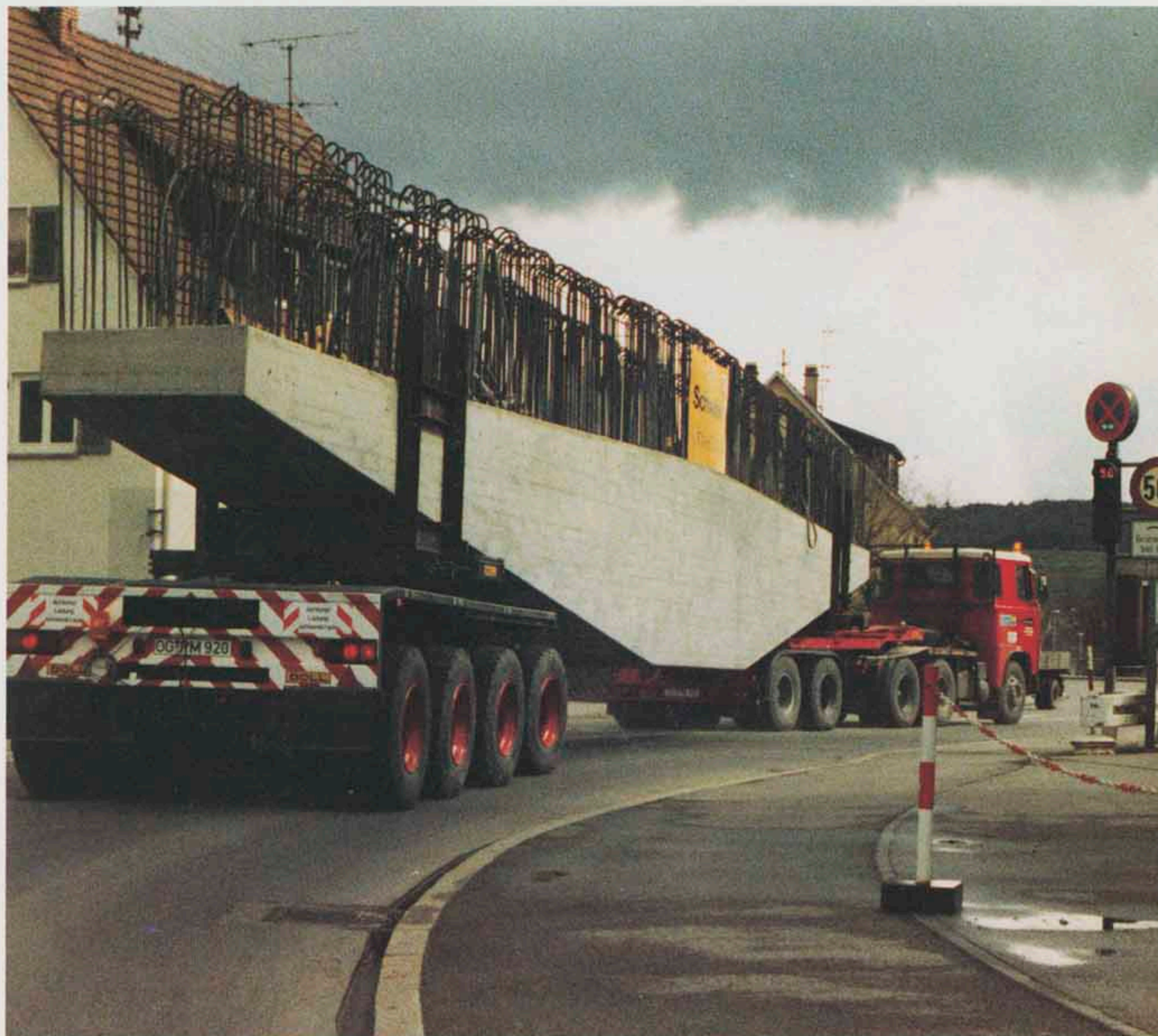
Beton-Auflagebalken für eine Brücke mit 74 Längsträgern.
